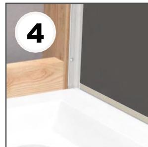
Tragen Sie auf die Rückseite des Multipanel® unseren Klebstoff auf, schieben Sie das Paneel in die Innenecke und drücken Sie das Paneel dann fest an die Wand.
