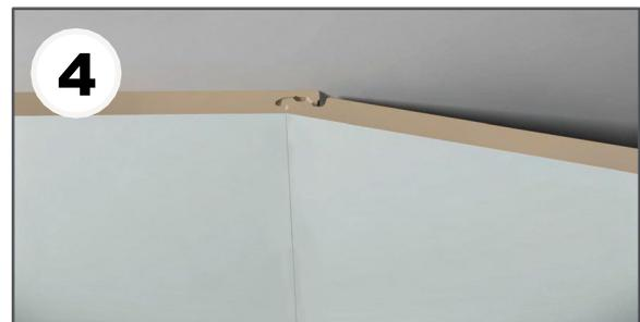
Setzen Sie das nächste Paneel in einem Winkel von zunächst 45° an der Nut des bereits montierten Paneels an. Stellen Sie dabei sicher, dass die Feder auf ganzer Paneellänge in der Nut des ersten Paneels setzt, bevor Sie das zweite Paneel an die Wand drücken, um eine Beschädigung der Nut- und Feder-Verbindung zu vermeiden.
